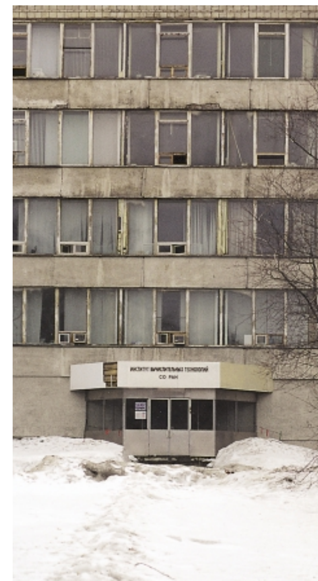
DIE TRISTE FASSADE VERRÄT NICHTS VOM NEUEN INNENLEBEN.
